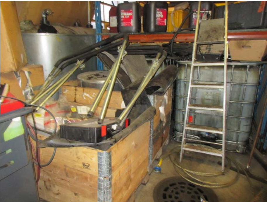
Kuva 6. Ahdas ja epäsiisti säilytystila, jossa varastoidaan vaarallisia nestemäisiä jätteitä aivan viemäriin vieressä ilman suoja-allasta. Vuototilanteessa nestemäinen vaarallinen jäte pääsisi suoraan viemäriin.
