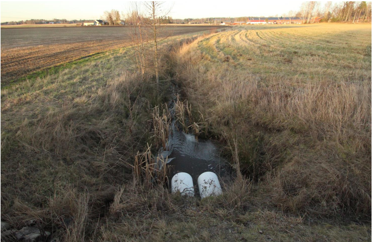
Yläkuvassa 5c taustalla, jossa maita kasattu ojan vierelle (punainen nuoli). Kuvattu Koivumäentieltä etelään. Alakuva samasta kuvauspaikasta kuvaussuuntana pohjoinen eli ojan alajuoksu. Ojaan olisi hyvä saada kaksitasouoma, mutta pellon suojakaistat ovat kapeat, varsinkin kuvassa ojan oikealla puolella. 7.12.2020.
