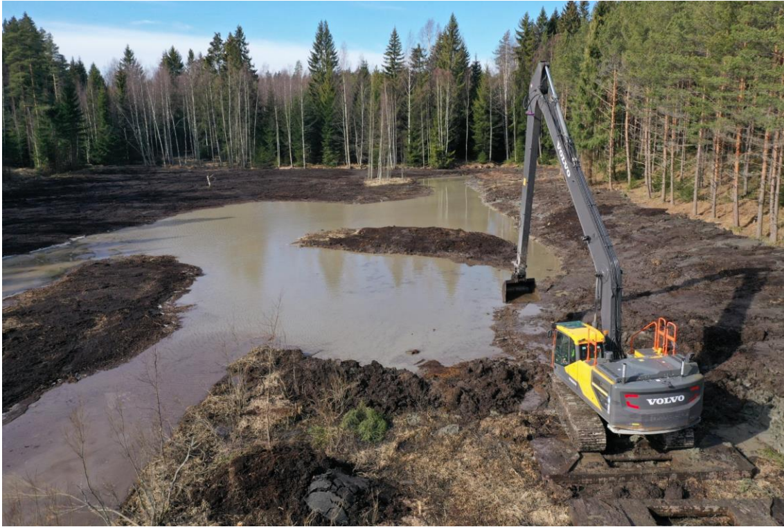
Kuivapintaiset matalat saaret ja loivat reunaluiskat luovat mm. vesilinnuille monimuotoisia ruokailu- ja levähdyspaikkoja ja ovat lähimaiseman kannalta eduksi. Inkoon Villmosskärrin kosteikko 2020 Juha Siekkinen.
