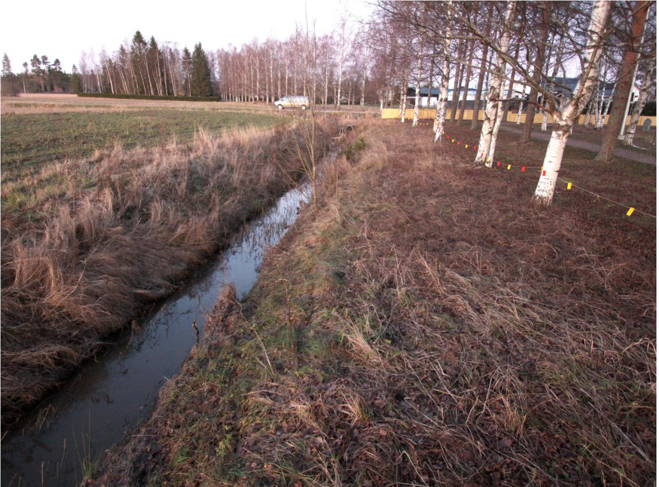
Kohde 5f kuvattuna puolivälistä koilliseen kohti Rusutjärventietä. Rakenteeksi ehdotettu kaksitasouoma tulisi koivurivistön ja ojan väliin. Tulvatasanne olisi mahdollista tehdä, jos 0,5:1 kaltevuudessa olevan luiskan kaivu aloitetaan 1 m:n päässä koivurivistöstä ja kaivussyvyys 100–120 cm. 7.12.2020.
