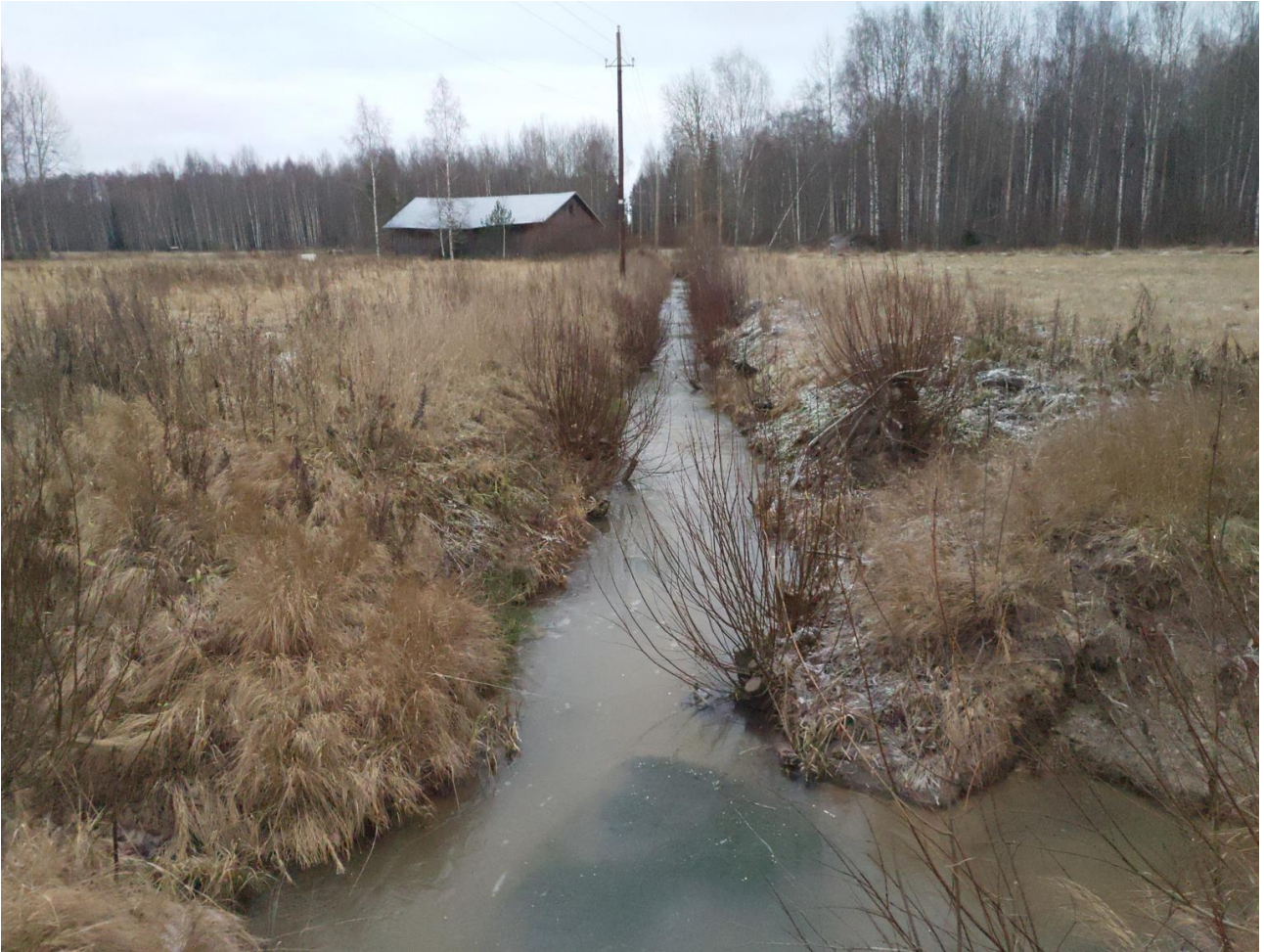
Kohteen 7e kaksitasouoman alue Vetikonojassa kuvattuna Vetikontieltä koilliseen. Kaksitasouomalle vaikuttaisi olevan riittävästi tilaa ojan molemmin puolin. Taustalla lato, jonka eteläpuolelle sen ja ojan väliin voi kaivaa pienen laskeutussyvänteen (kohde 7d). 9.12.2020.
