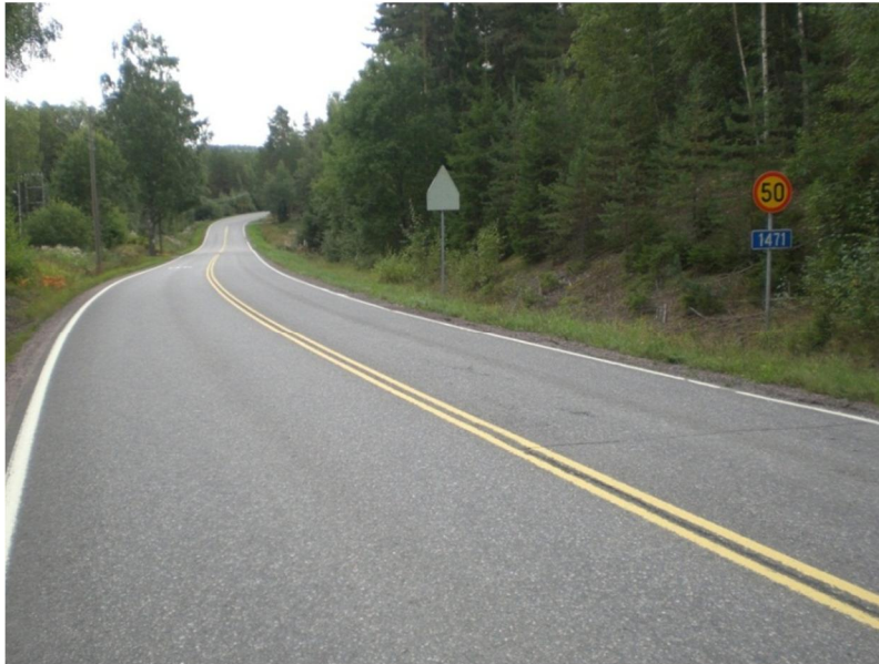
Kuva 21. Lukon vedenottamo sijaitsee Sälinkäntien (1471) välittömässä läheisyydessä.
