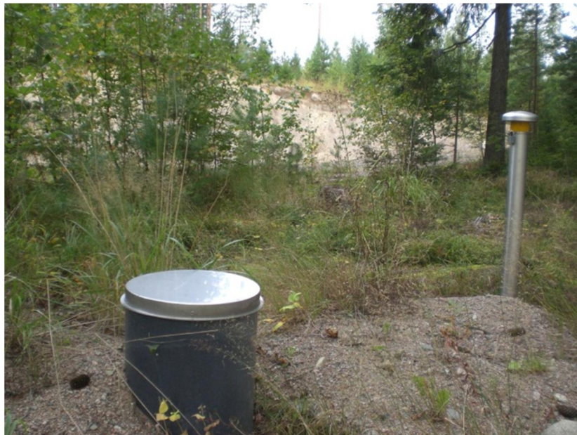
Kuva 14. Levannon vesiosuuskunnan vedenottamon pohjoispuolelle on rakennettu uusi siiviläputkikaivo.
