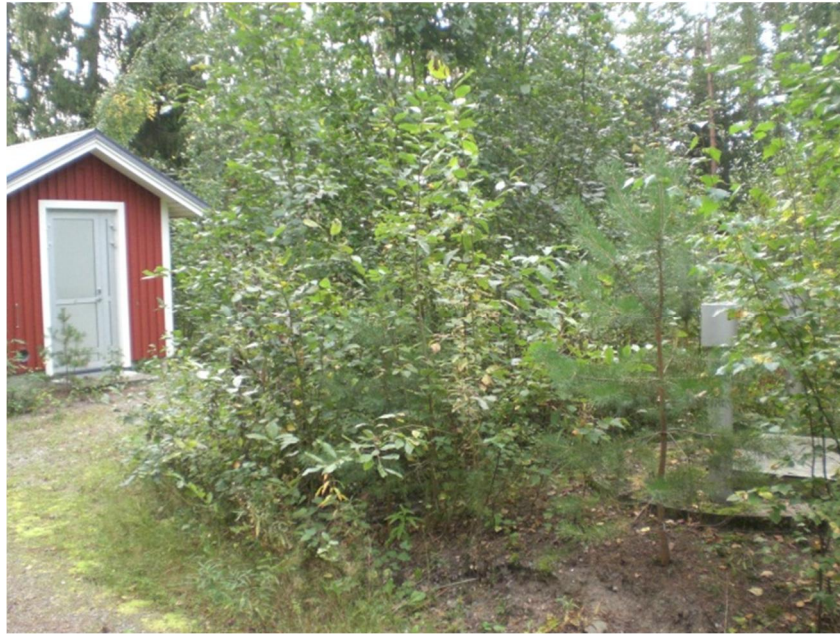
Kuva 13. Levannon vesiosuuskunnan vedenottamo sijaitsee Avojärvenojan läheisyydessä.
